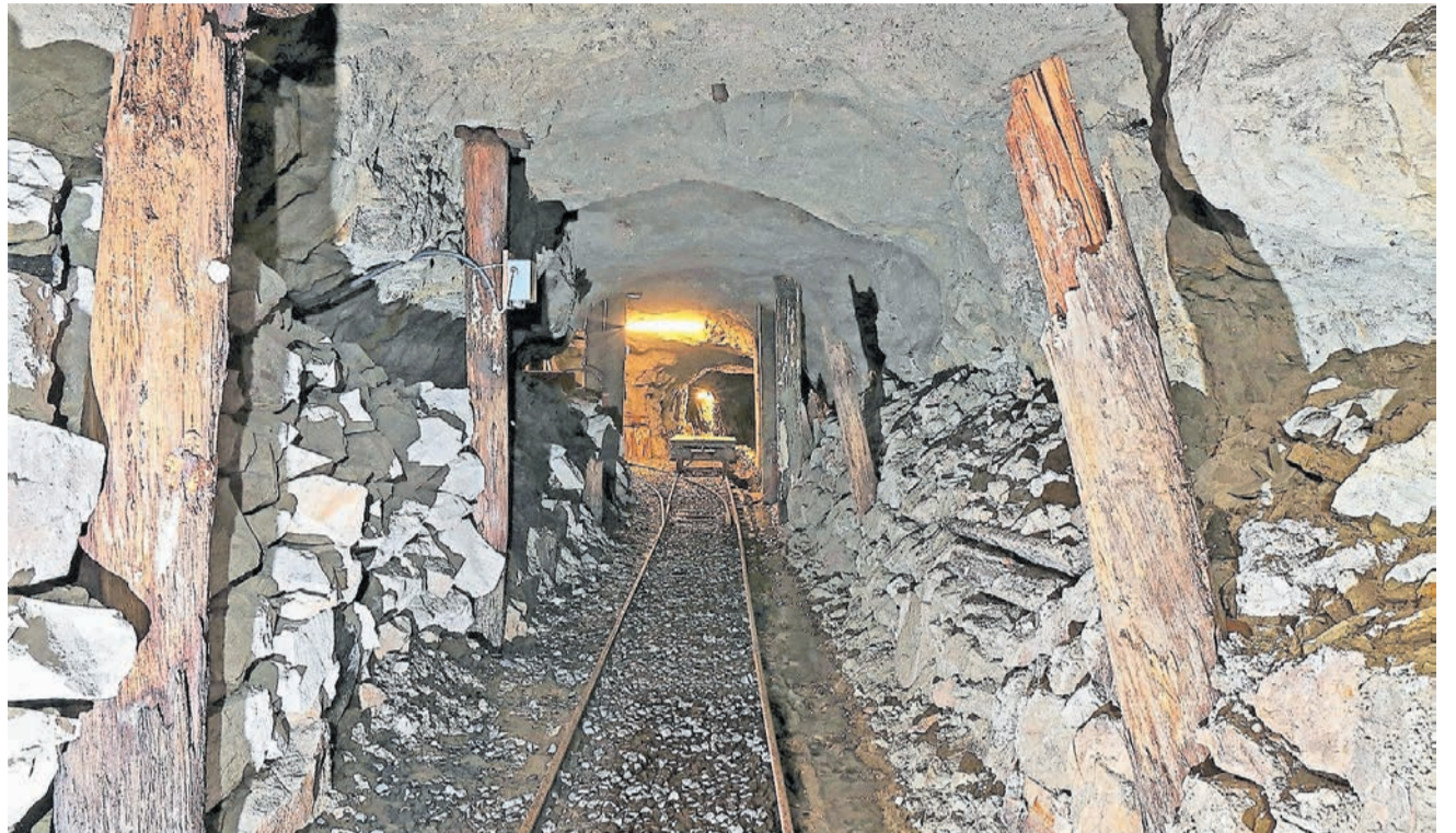
Blick in den Gottertstollen im Bergwerk Riedhof. (Bild R. Widmer)
