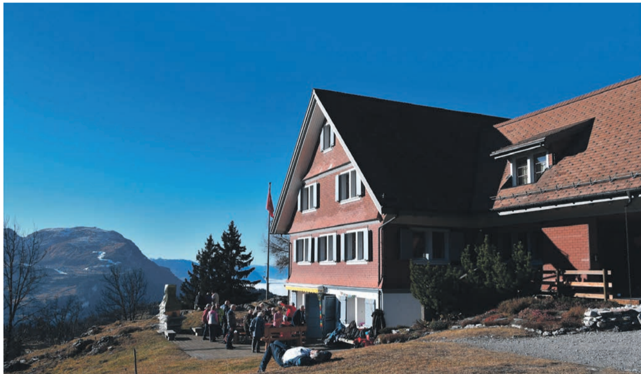
Wunderschön, aber aufwändig im Unterhalt und im Betrieb: Die Hütte Eseltritt gab zu reden. (Bild zvz.)
