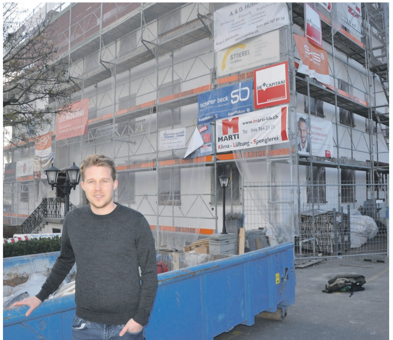
Miro Hegnauer, Kommunikationsverantwortlicher der Genossenschaft, vor dem eingerüsteten «Rössli». Trotz Mehrkosten werden Restaurant und Bar im Mai eröffnet, und die Apartments sind im Juli 2023 bezugsbereit. (Bild Werner Schneider)
