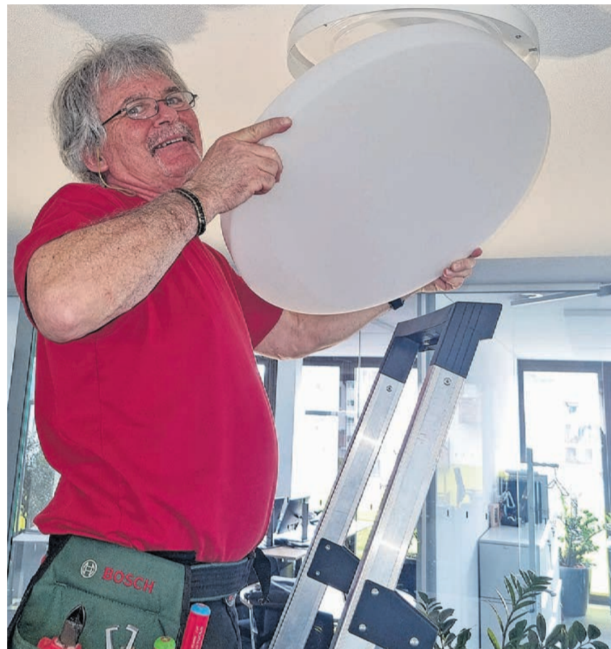
Haustechniker Reto Frick montiert im Stadthaus eine neue LED-Leuchte. (Bild zvg.)
